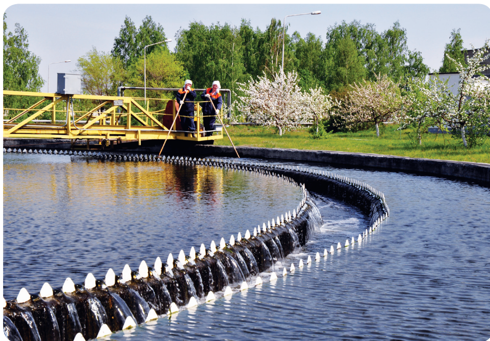
Вторичный отстойник на очистных сооружениях «Челныводоканала»
